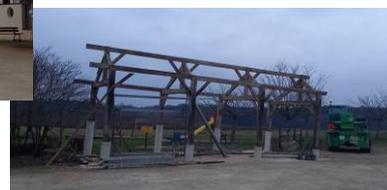
Après le terrassement et le coulage des poteaux de support, la charpente, une fois démontée, a été reconstruite sur le parking de la salle des fêtes pour la réalisation d'un abri. Une plaque, rappelant l'origine de la charpente, sera apposée.
