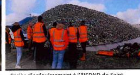
Casier d'enfouissement à l'ISDND de Saint Laurent des Hommes. *Installation de stockage de déchets non dangereux
